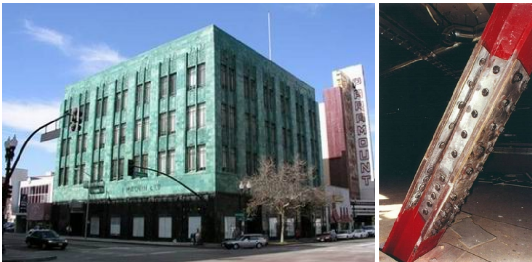
Retrofit con SBC al Edificio I. Magnin (1930), Oakland, USA.
